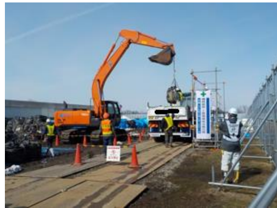
除染土壌等の積み込み確認
