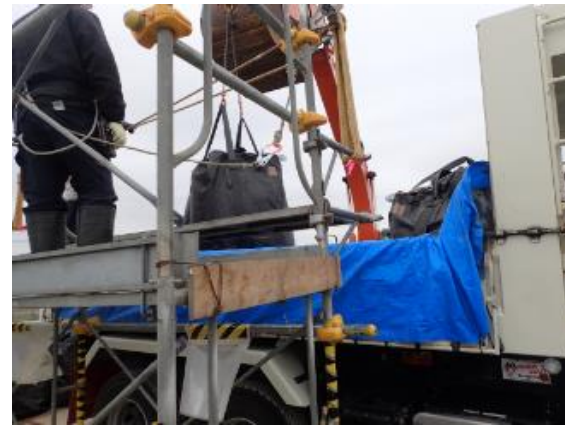
除染土壌等の積み込み確認
