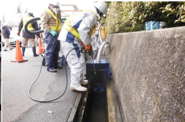
写真4 側溝除染(洗浄)
