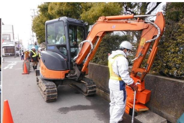
写真6 側溝蓋再設置
