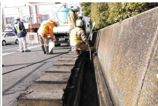
写真10 側溝下流（堰き止め）汚泥回収
