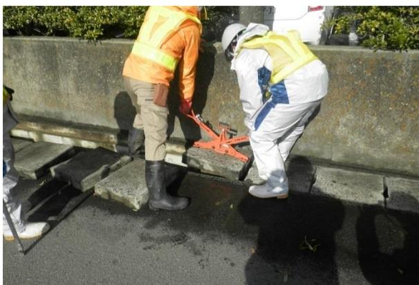
写真11 側溝蓋再設置
