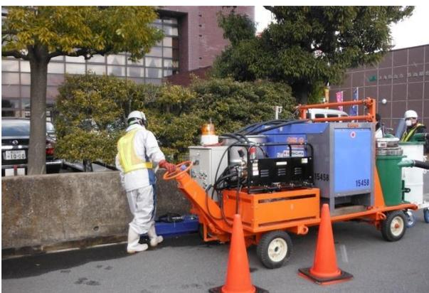
写真5 側溝汚泥回収洗浄装置を台車牽引
