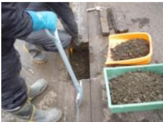
写真12 路盤材料採取状況
