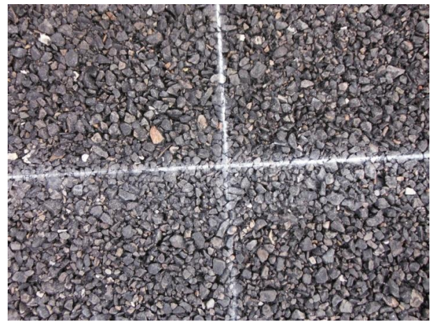
写真4 実証技術による作業後の舗装表面(G)
