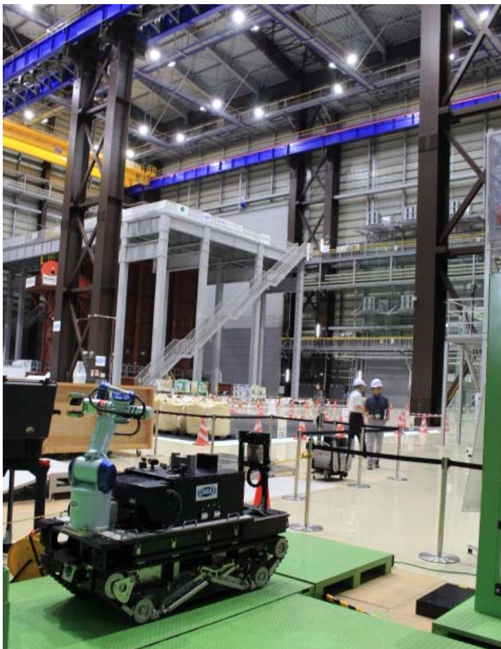
天井まで高さ40mもある試験棟。原子炉建屋と同寸のモックアップ施設が置かれている
