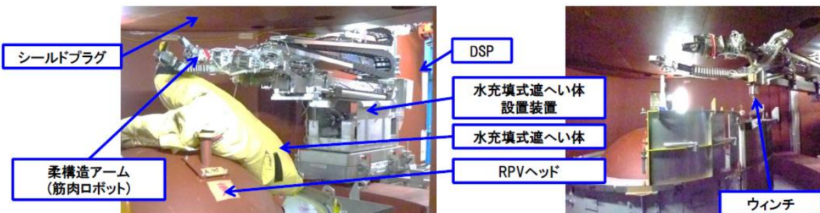
水充填式遮へい体設置装置
