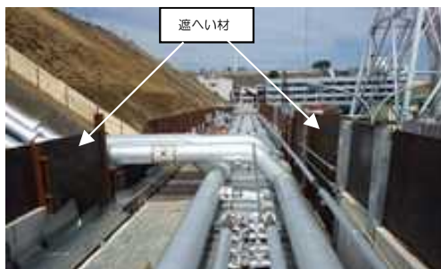
<3-4 陸側遮水壁工事で実施した遮へい>
