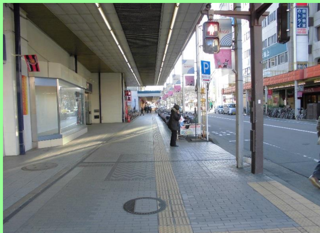
①南1ブロック工事着手前(平成29年2月28日撮影)
