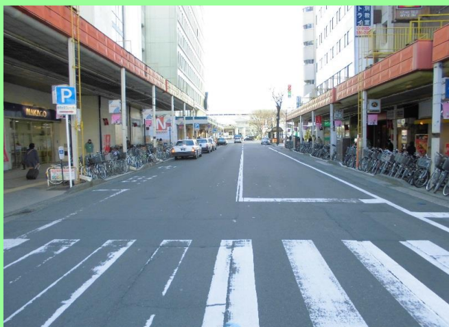
②車道工事着手前(平成29年1月10日撮影)
