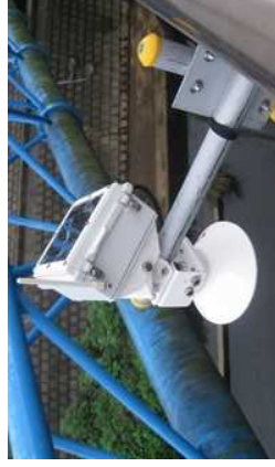
洪水に特化した低コストな水位計の設置例
