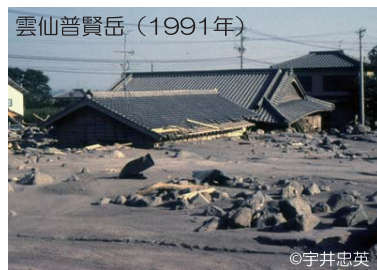
降灰後の土石流
