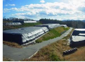
長屋地区仮置場
