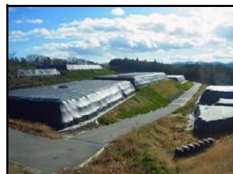
長屋地区仮置場
