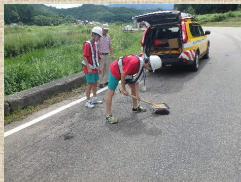
道路パトロールでは、舗装の応急処置を体験しました
