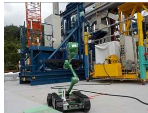
小型ロボットによる監視
