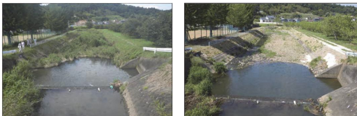
図 5.6 除染対策の実施前（左）・実施後（右）の河川敷（福島県提供）
