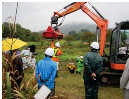
効率的な除草のため除草機械の実証実験
