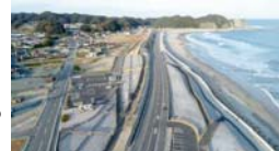
豊間防災緑地(いわき市)(H31.3完了予定)
