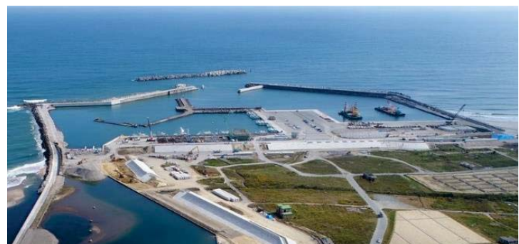
【漁港の復旧状況】請戸漁港(浪江町)
