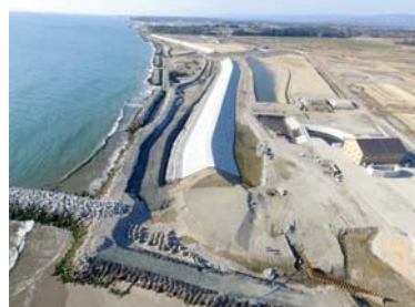
【海岸堤防の復旧状況】 小沢地区海岸(南相馬市)
