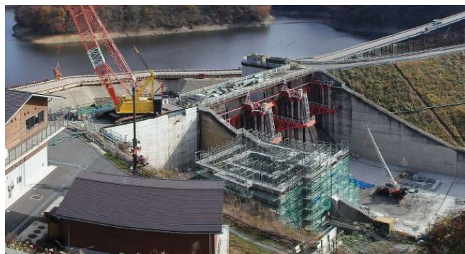
千五沢ダム(石川町)【整備状況】洪水吐き整備状況
