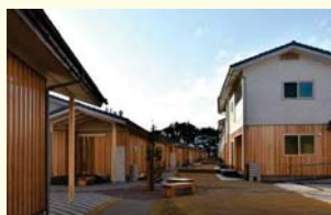
勿来酒井団地(いわき市 H30.3完成)
