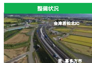
<会津縦貫北道路 4工区供用区間>
