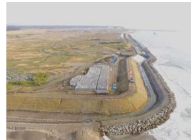
【海岸堤防の復旧状況】 双葉中浜地区海岸(双葉町)
