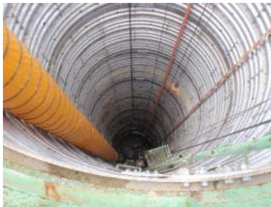
— NO.1 集水井内の施工状況 — (H30.8.7)
