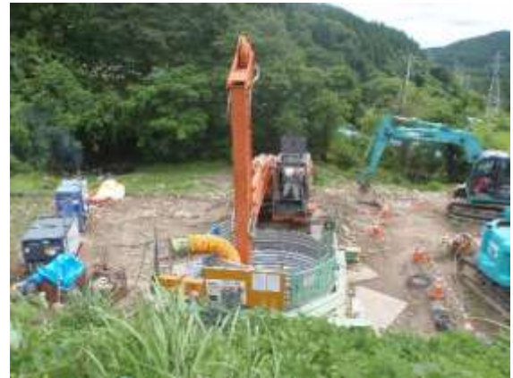
— NO.1 集水井の掘削状況 — (H30.8.7)
