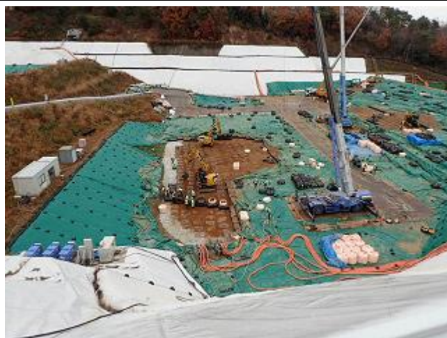
下流側埋立地の埋立状況の確認
