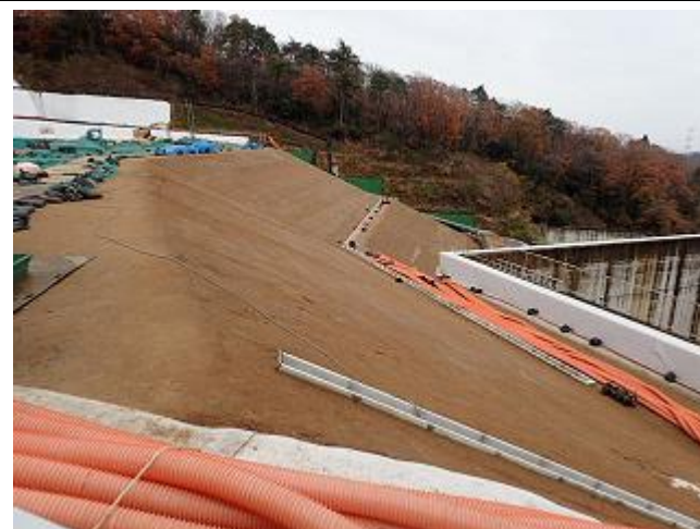
土堰堤の法面の確認
