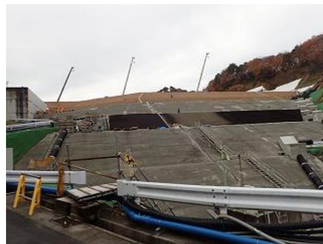
下流側堰堤の確認
