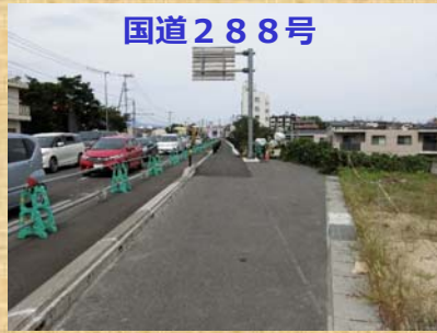
国道288号 拡幅 東側
