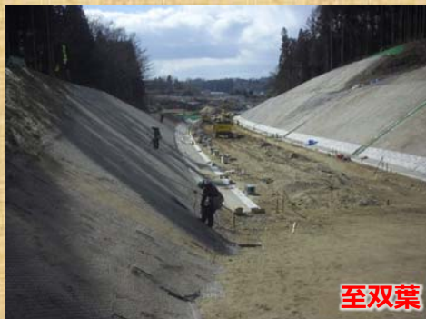
2工区工事状況
