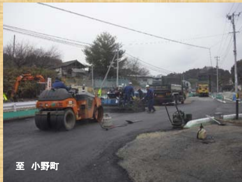
現在の工事状況
