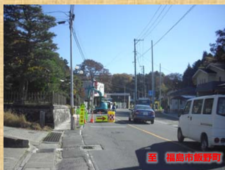
現在の工事状況
