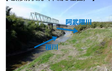
【改修前状況(下流1工区)】
