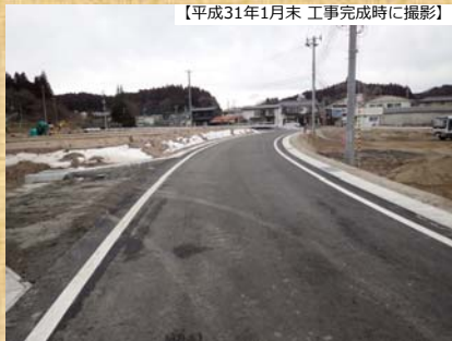
車川と合流付近の町道付替工事完成写真
