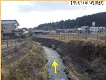
小野橋下流部 家屋移転前後状況写真
