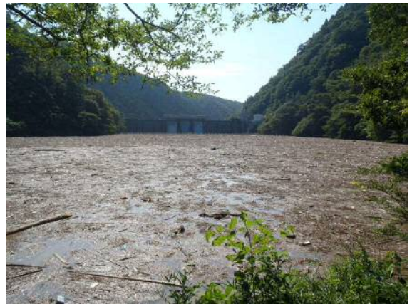
高柴ダムに押し寄せる流木（上流側より）
