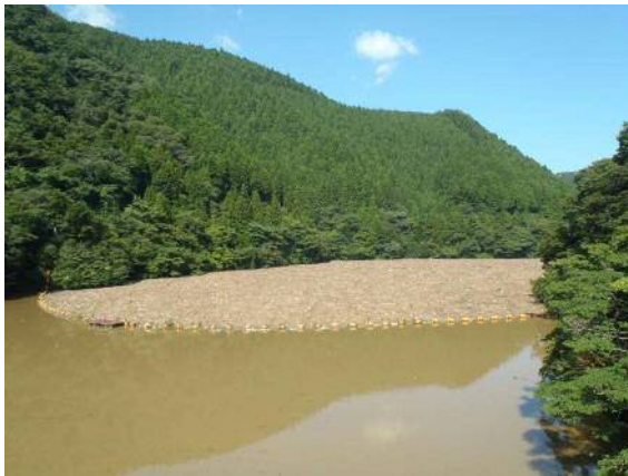
高柴ダムに押し寄せる流木（堤体より）
