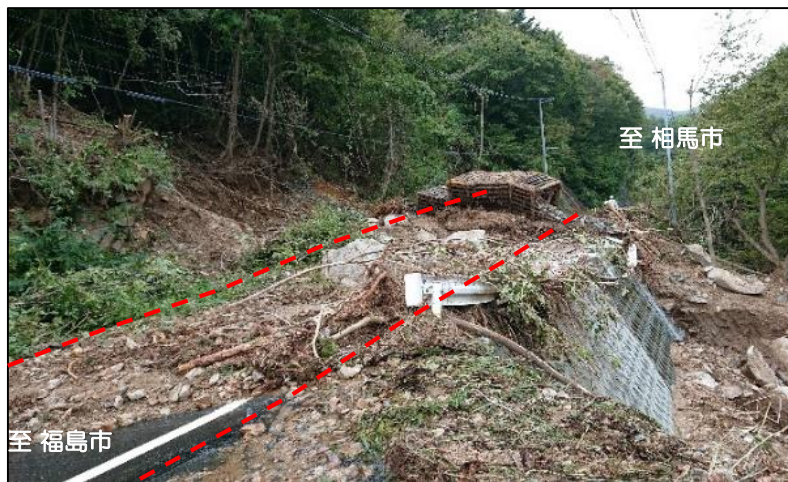
国道115号(相馬市東玉野地内)
