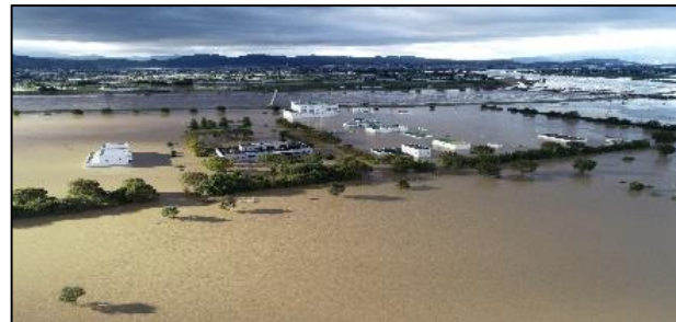
県北浄化センター（国見町大字徳江地内）
