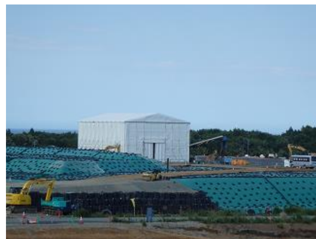
土壌貯蔵施設の稼働状況の確認
