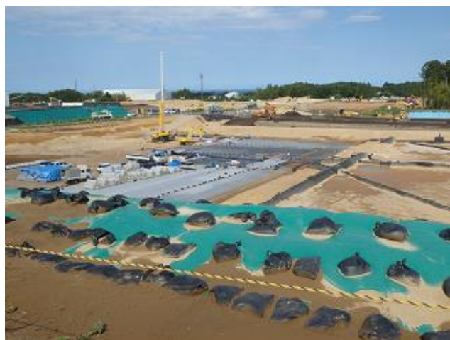
土壌貯蔵施設の稼働状況の確認
