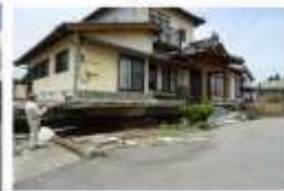
約1.3mの段差が発生
