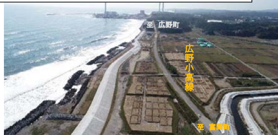
広野小高線 檜葉工区(檜葉町) 整備状況
