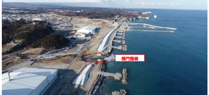
【堤防の整備】 毛萱仏浜地区海岸(富岡町)
