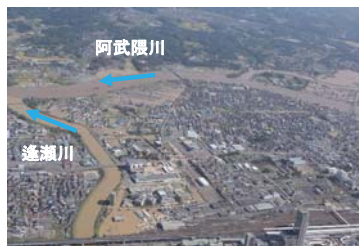
逢瀬川(郡山市) 【出水状況(R元.10月)】 洪水氾濫を防ぐための河川整備を推進
