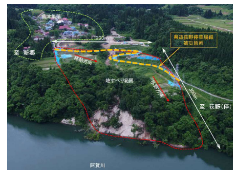
被災箇所写真
