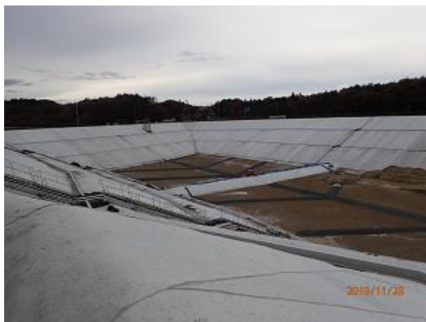
土壌貯蔵施設の稼働状況の確認
