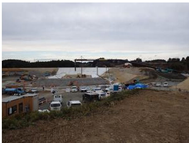
土壌貯蔵施設の設置状況の確認
