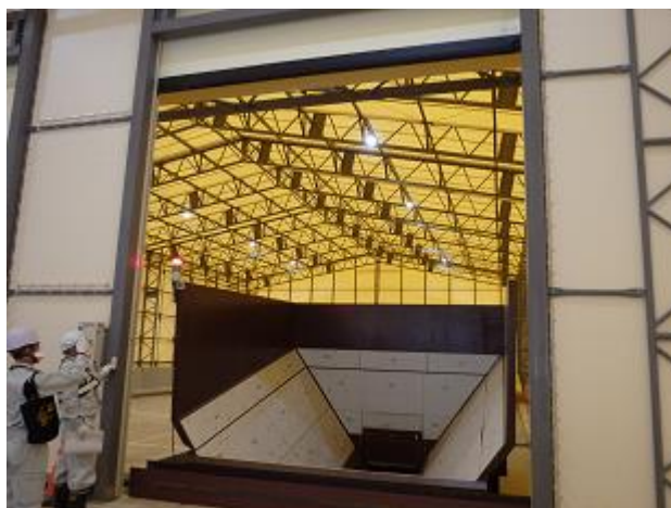
土壌貯蔵施設の設置状況の確認
