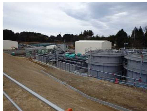
浸出水処理施設の設置状況の確認
