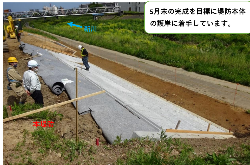
堤防コンクリート張ブロック施工中
