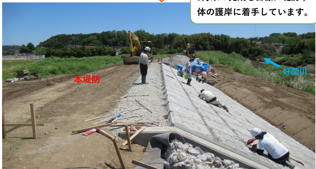
川表護岸施工中
