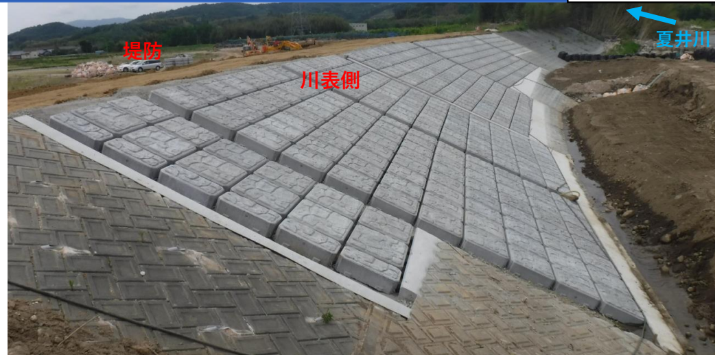
川表側 コンクリート張ブロック完了
