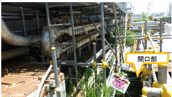
(写真 2 - 1) 溜まり水移送前 (令和元年 6 月 13 日 撮影)
