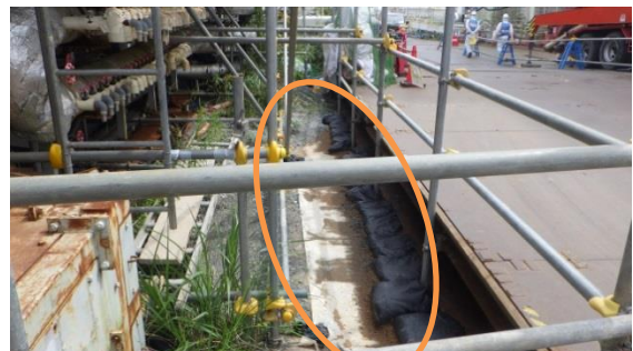
(写真 2 - 2) 今回 (令和元年 9 月 13 日 撮影) 【楢円内が埋め戻し箇所】
