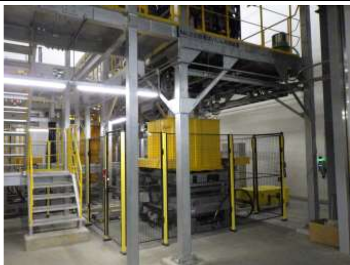
仮設灰処理施設の設置状況の確認
