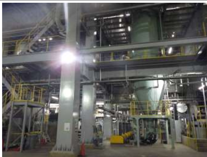
仮設焼却施設の設置状況の確認
