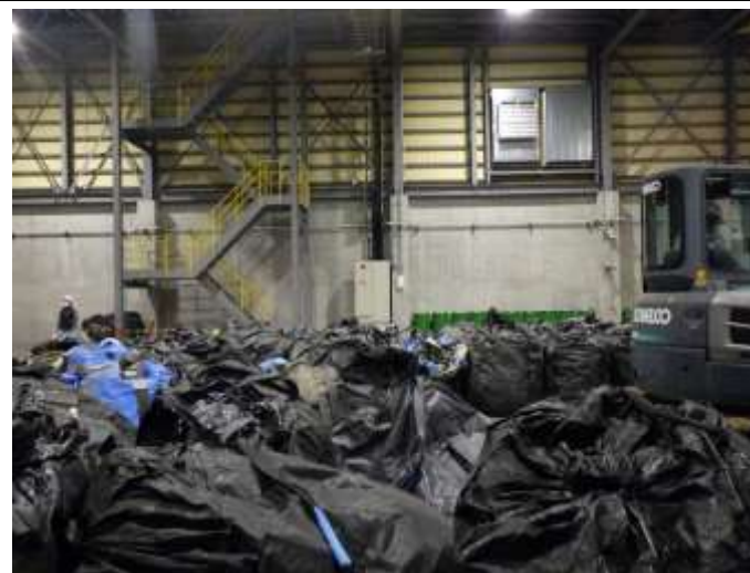
同左 受入ヤードの稼働状況確認
