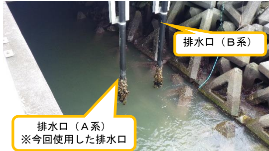
(写真4) サブドレン排水箇所（排水口）の状況
