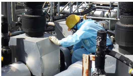
(写真2) 排水開始後のポンプの点検状況
