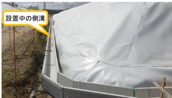
(写真2) 雨水排水工事の状況 (第2槽の状況)
