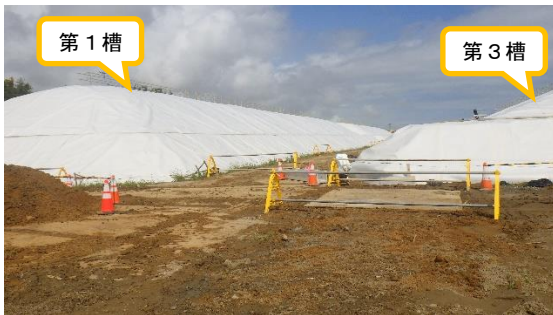
(写真1-2) 第1槽及び第3槽の状況
