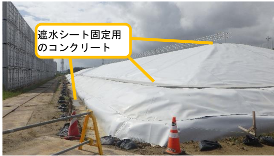
(写真1-3) 遮水シートの固定状況 (第4槽の状況)
