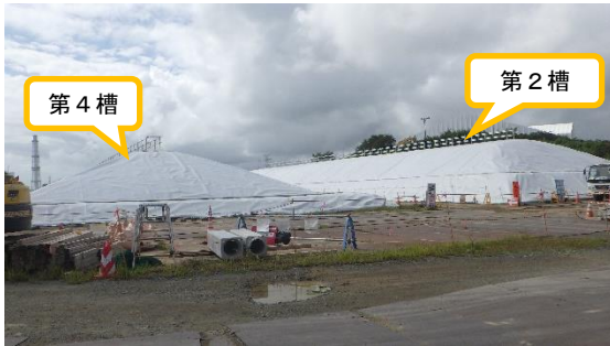
(写真1-1) 第2槽及び第4槽の状況
