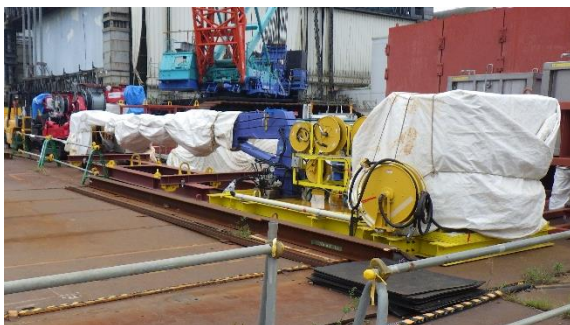
(写真3) 資機材のロープ固縛の例（1号機原子炉建屋北西側）
