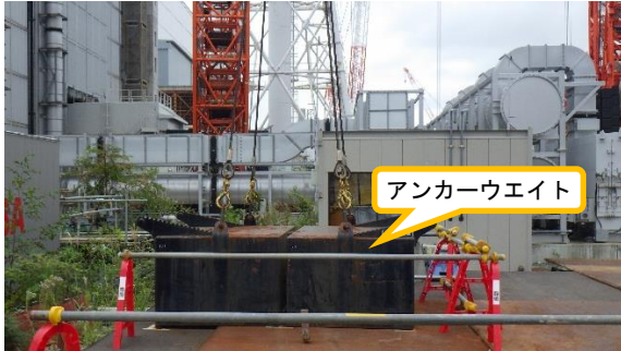
(写真1) クローラクレーンの強風対策の例
