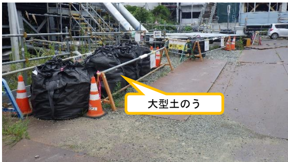
(写真2) 大熊通り下端にあらかじめ仮置きされていた大型土のう
