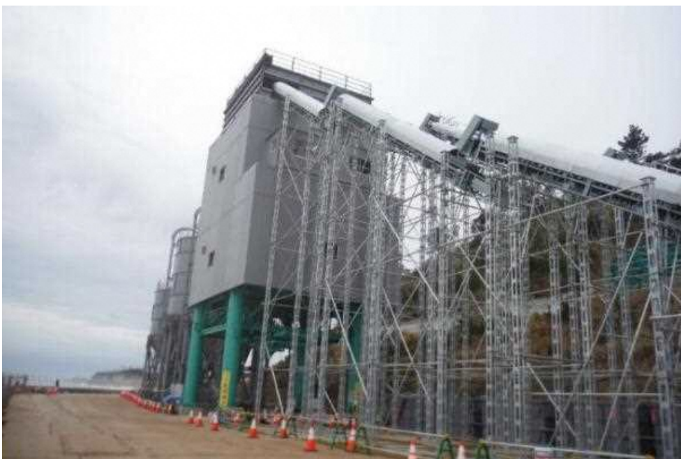
写真①：製造プラント全景
