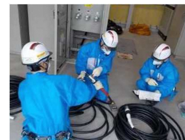
ケーブル導通訓練
