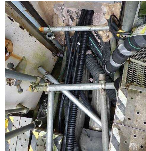
写真2：配管貫通部の状況例
