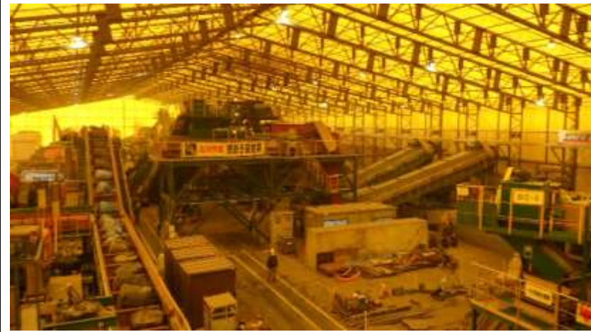
受入・分別施設の分別処理状況の確認
