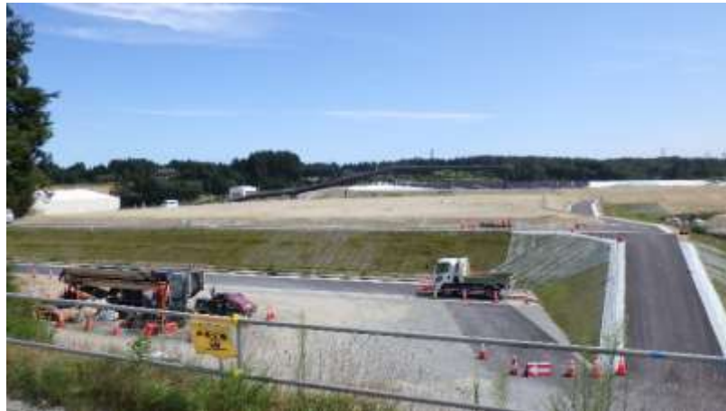
土壌貯蔵施設（東側）の埋立状況の確認
