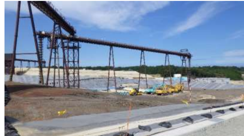
土壌貯蔵施設（西側）の埋立状況の確認
