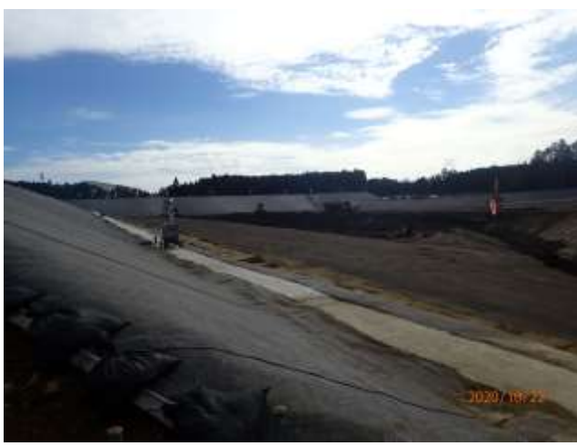
土壤貯蔵施設の埋立状況の確認
