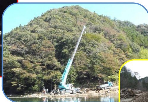
集積した流木類をクレーンでトラックに積み込み
