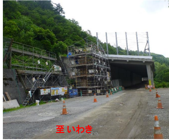
スノーシェッド工事状況
