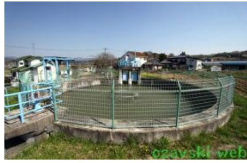
東根堰円形分水工(伊達市)
