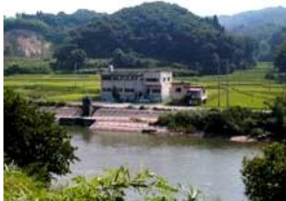
安達揚水機場（二本松市）
