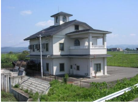
伊達崎排水機場（桑折町）
