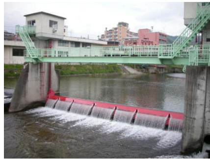
西根下堰頭首工（福島市）
