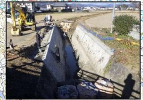
河川改修(いわき市)
