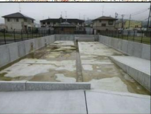
消防庁舎 浸水対策工事(いわき市)
