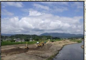
夏井川 河道掘削(県:いわき建設)
