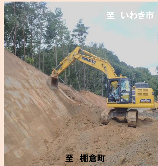
② 2工区 切土施工状況
