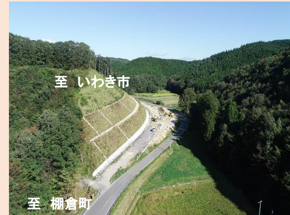
② 改良工の状況
