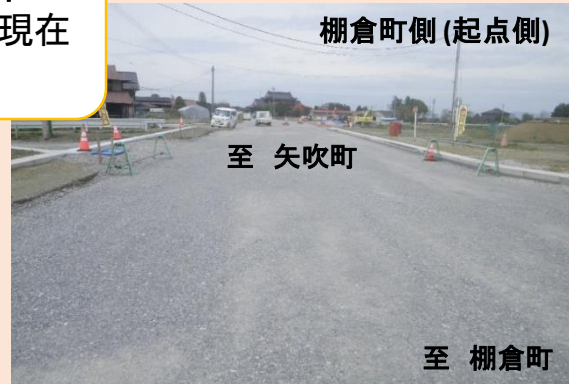
②施工状況
