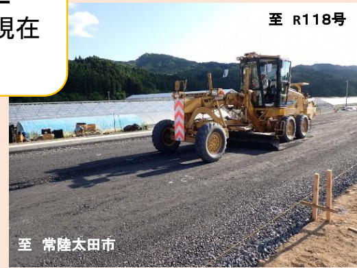
① 2工区 施工状況
