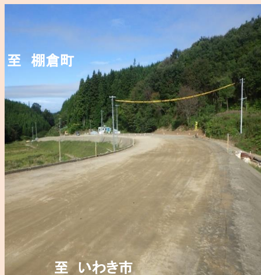
① 2工区 盛土施工状況
