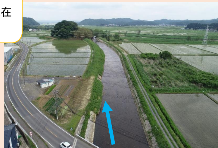
土砂撤去後の状況
