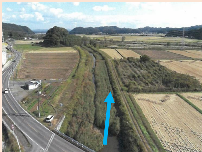
土砂等の撤去前の状況
