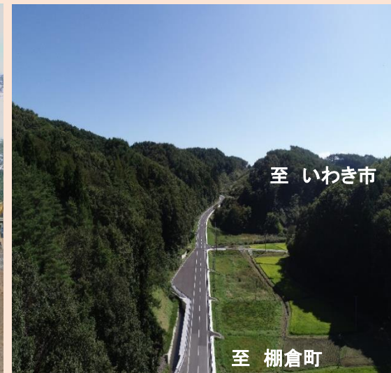
③ 3工区 舗装完了状況
