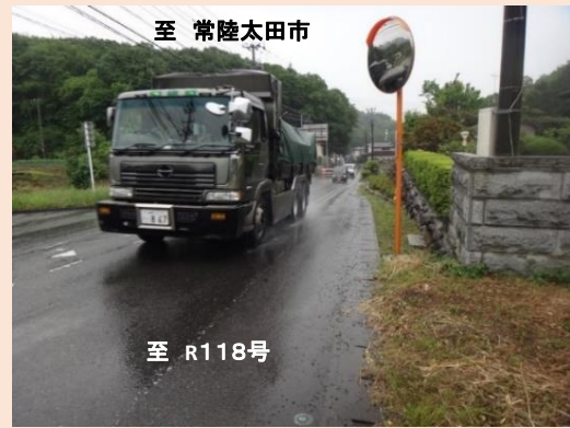
工事着手前(平成26年度)
