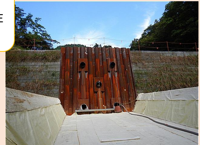
2号堰堤工の状況
