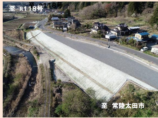
② 3工区 施工状況
