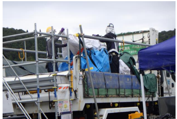
除去土壌等の積込作業
